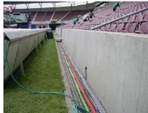
Tracé de câbles autour du terrain de jeu
